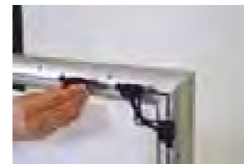
Mausbinder in die Nut des Rohres stecken
