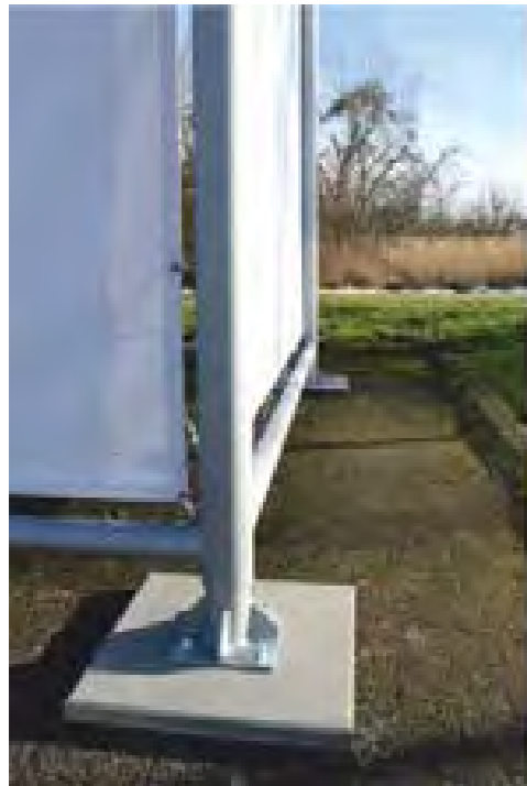
Stahlstandpfosten mit Knotenblechen und Sockelplatte, verzinkt.
